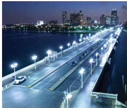
Cobrahead luminaires
