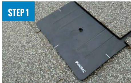
INSTALL FLASHKIT PRO FLASHING
